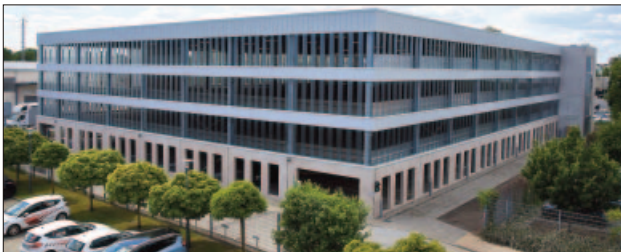
■ Das neue Parkhaus bietet Platz für 377 Autos und ist mit modernster Technik besonders benutzerfreundlich.
