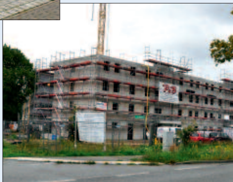
■ Bernau ist momentan eine Stadt der Baukräne, da immer mehr die Reize der Barnim-Metropole als Wohnstandort im Grünen für sich entdecken.
