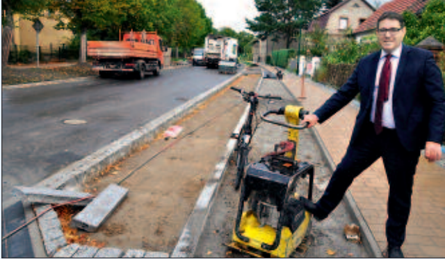
■ In Schönow ist der Ausbau des Dorfkerns in den letzten Zügen.
