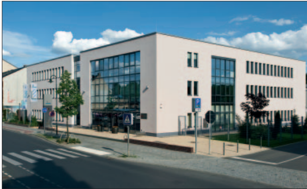
■ Der Firmensitz der Stadtwerke Bernau in der Breitscheidstraße liegt zentral in der Innenstadt und ist gut über den ÖPNV erreichbar.
